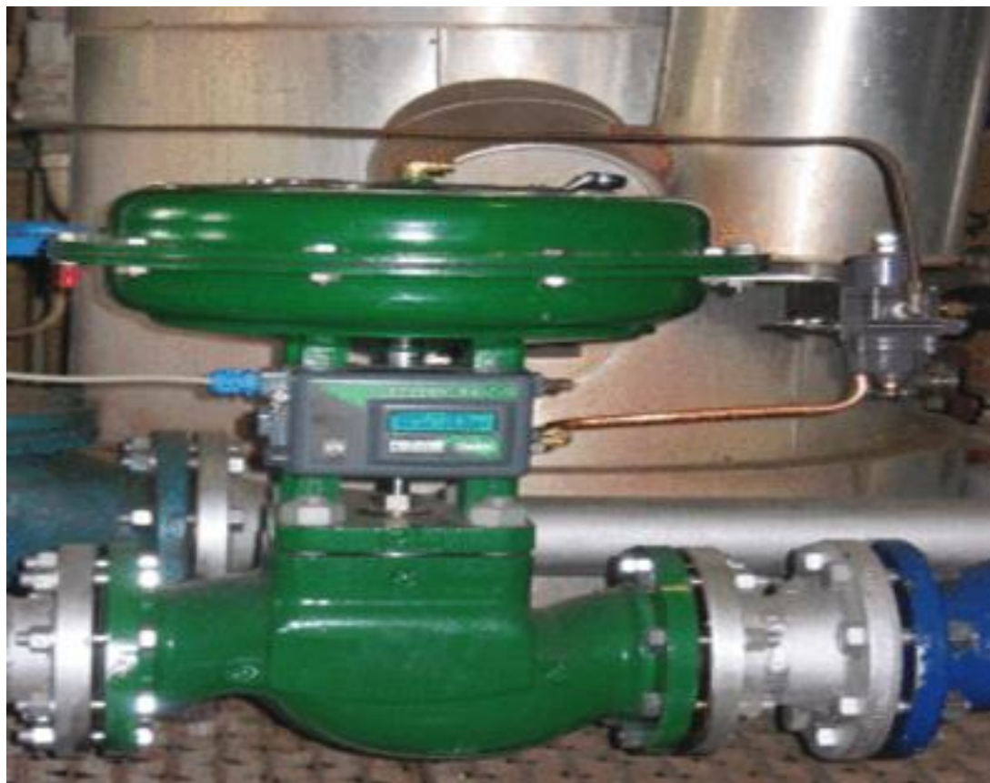
2.2 Сурет – Мембраналы пневможетек
